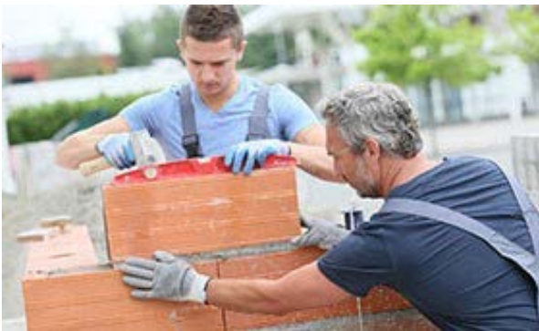
Ist die Mauer gerade? Der Ausbilder schaut genau hin. Bild: goodluz | Adobe Stock
