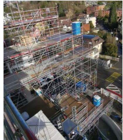
Gerüstbau in der Schweiz
