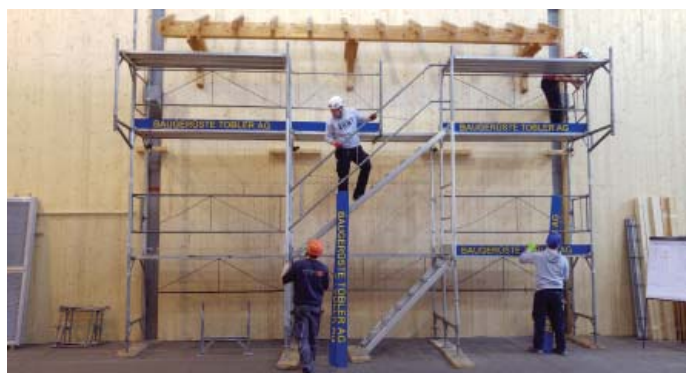
Arbeiten mit Tobler-System
