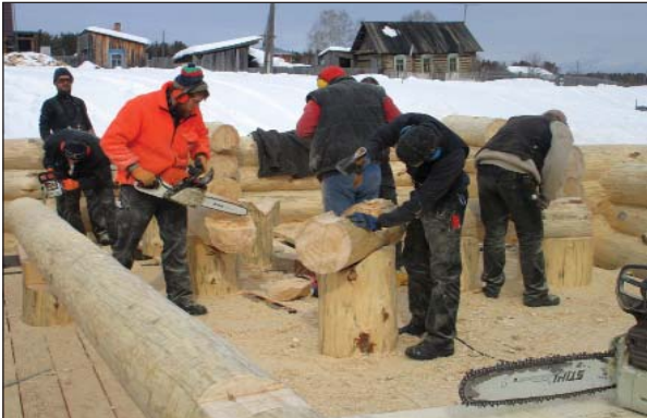
Arbeiten auf der Baustelle
