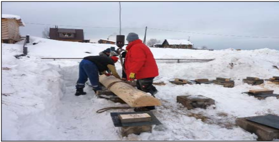
1. Lage wird aufgebracht
