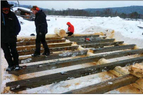
Einlegen der Bodenbalken
