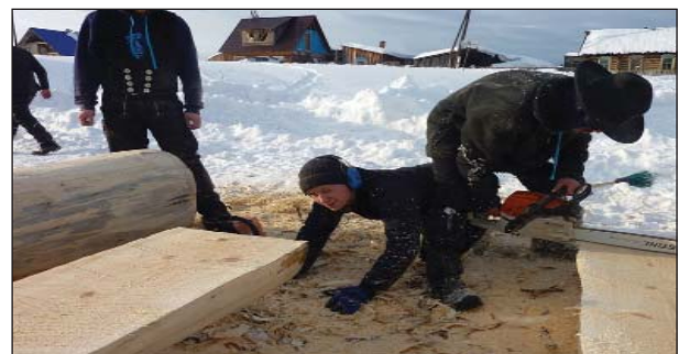
1. Lage wird aufgebracht
