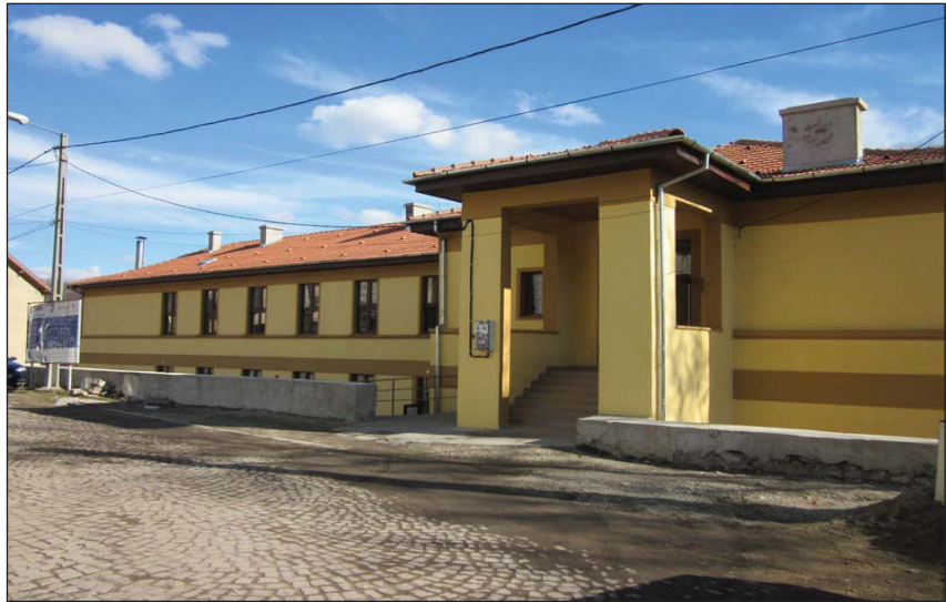
Das sanierte Schulgebäude
