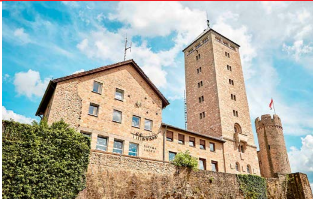
Ende September 2020 konnte die Jugendherberge Starkenburg in Heppenheim an der Bergstraße nach umfassender Renovierung wieder die Burgtore öffnen, um dann kurze Zeit später wieder coronabedingt schließen zu müssen. Das DJH Hessen investierte 1,1 Millionen Euro, das Land Hessen beteiligte sich mit einer Förderung von 300.000 Euro. (Foto: DJH Hessen)
