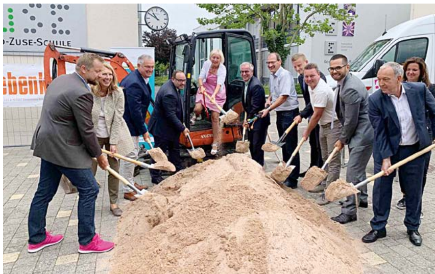
In Anwesenheit der hessischen Digitalministerin Prof. Dr. Kristina Sinemus (Mitte) fand am 5. August 2019 der erste Spatenstich für den Glasfaseranschluss der Konrad-Zuse-Schule, einer berufsbildenden Schule in Hünfeld, statt. Bis Mitte 2020 sollen 61 Schulen im Landkreis Fulda mit schnellen Glasfaseranschlüssen ausgestattet sein. Finanziert wird das Projekt aus Mitteln des Landkreises, des Landes und des Bundesministeriums für Verkehr und digitale Infrastruktur im Rahmen der Breitbandförderung des Bundes. Die Mittel aus dem „Digitalpakt Schule“ des Bundes und der Länder sind ausdrücklich nicht für die Anbindung der Schulen vorgesehen, sondern für die digitale Infrastruktur innerhalb der Schulgebäude (z.B. WLAN) und für Hardware. (Foto: Hessische Staatskanzlei, Ministerin für Digitale Strategie und Entwicklung)
