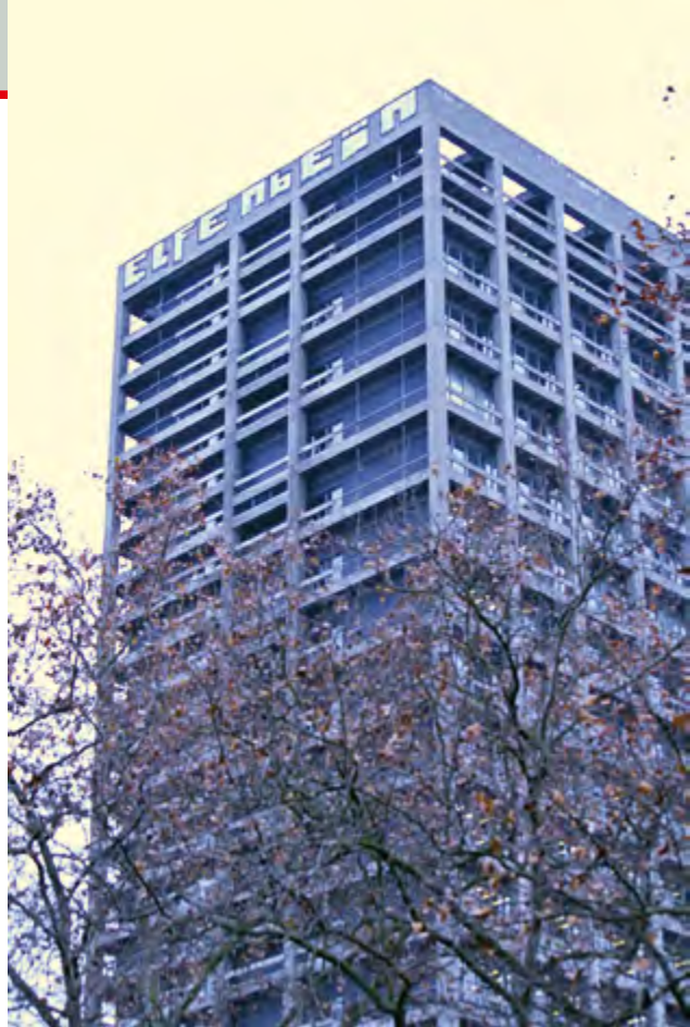
Der legendäre Betonturm der ehemaligen Abteilung für Erziehungswissenschaften (AfE-Turm) an der Goethe-Universität Frankfurt soll abgerissen werden. In einer nächtlichen Aktion wurde er von Aktivisten mit 38 Kilogramm weißer Farbe als „Elfenbeinturm“ veredelt. Einst ein Kampfbegriff gegen eine selbstverliebte Wissenschaft ohne gesellschaftlichen Bezug protestieren die anonymen Maler jetzt gegen den Umzug der Erziehungs- und Gesellschaftswissenschaften auf den Campus Westend in das geistige Umfeld von Stiftungsprofessuren und Sponsorengeldern für das „House of Finance“. (Foto: Karina Lakeeva-Freiling)
